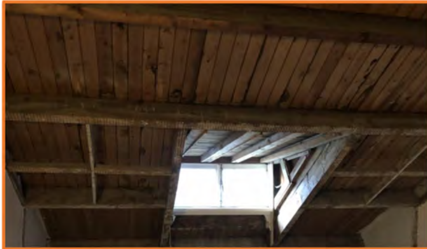
Stap 1: Stucwerk verwijderen
