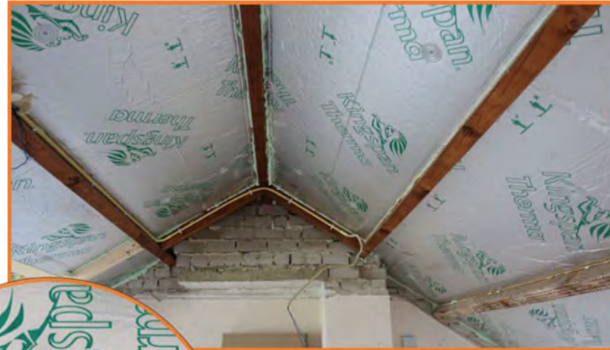
Stap 2: PIR platen aanbrengen
